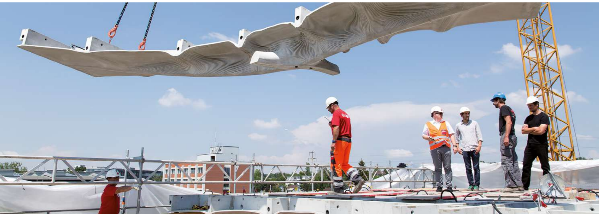
Встановлення плити Smart Slab Фотограф: Andrei Jipa
