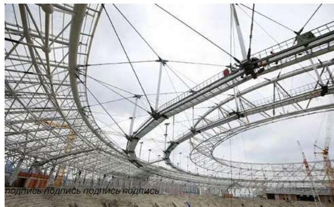
Об'єкт: Chengdu Phoenix Mountain Sports Park, Ченду, КНР — конструкція вантового купола Фотограф: China Construction Eighth Engineering Division Corp.Ltd.
