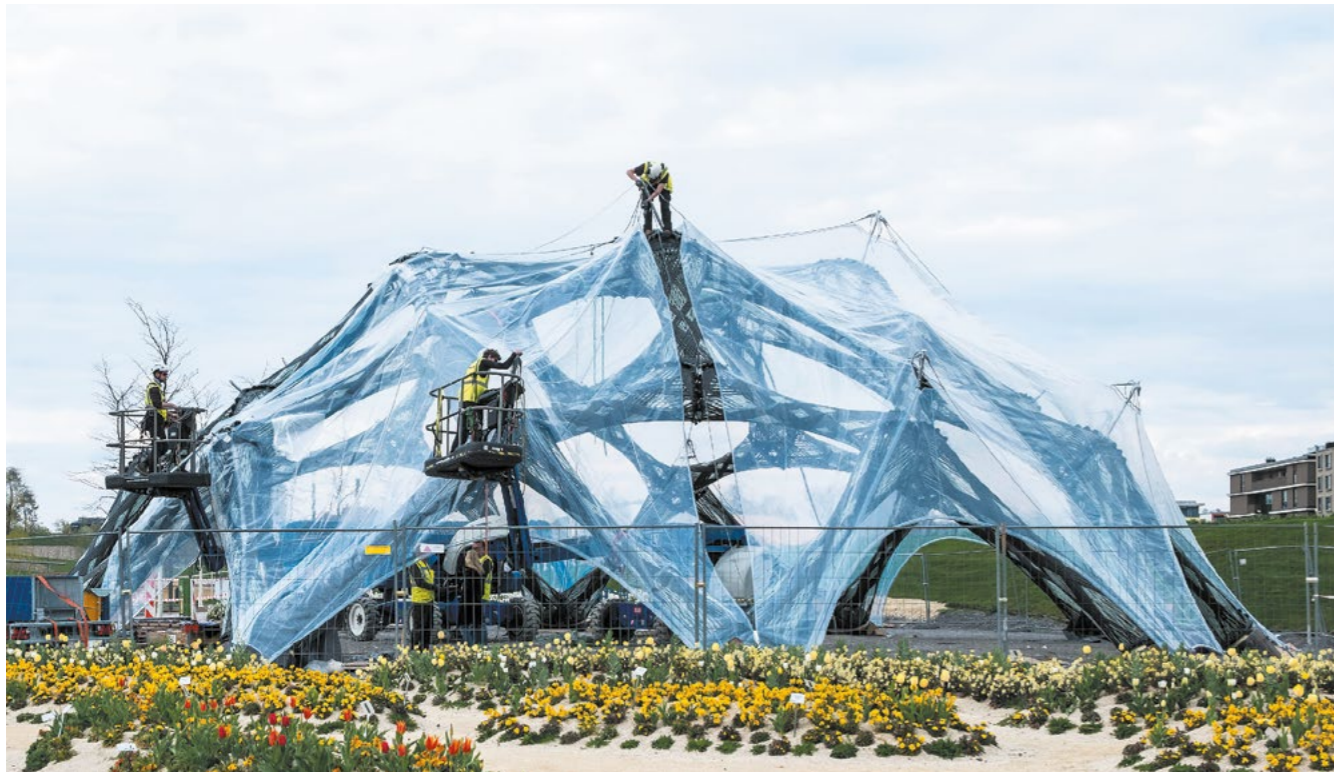
Монтаж ETFE-мембрани Джерело: ICDITKE University of Stuttgart
