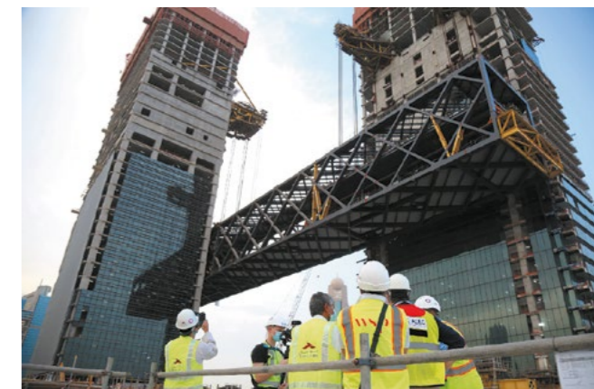
Підняття моста Джерело: Nikken Sekkei
